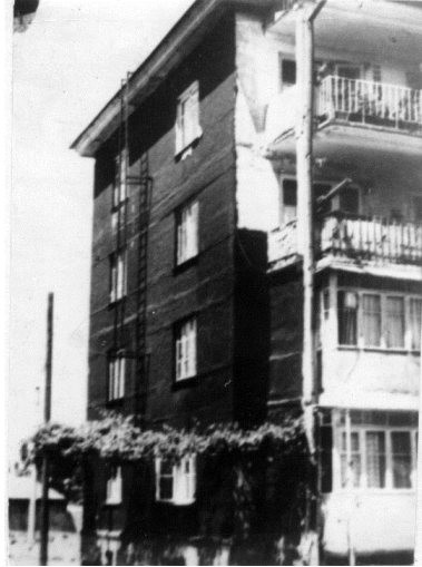
ნახ. 10. კედლის ზედაპირის ჰიდროიზოლაცია მთლიანად ბიტუმით
