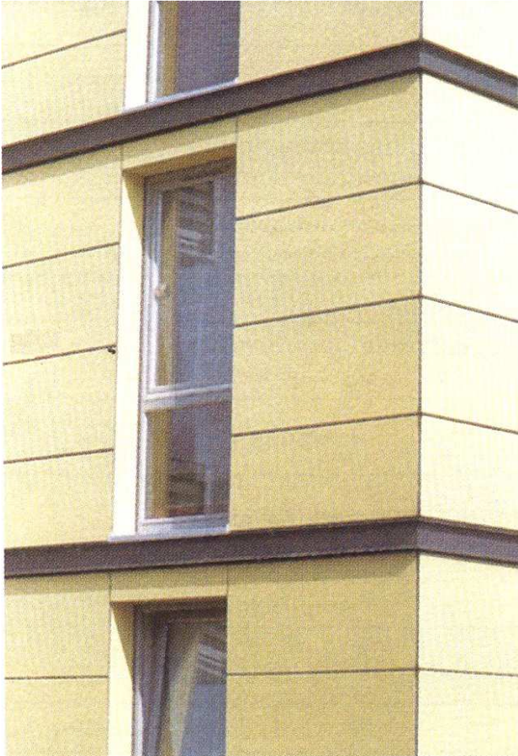
ნახ. 17. საცხოვრებელი სახლის ფიბროცემენტის ეკრანებით მოპირკეთება ქ. ჰანოვერში (გერმანია)
