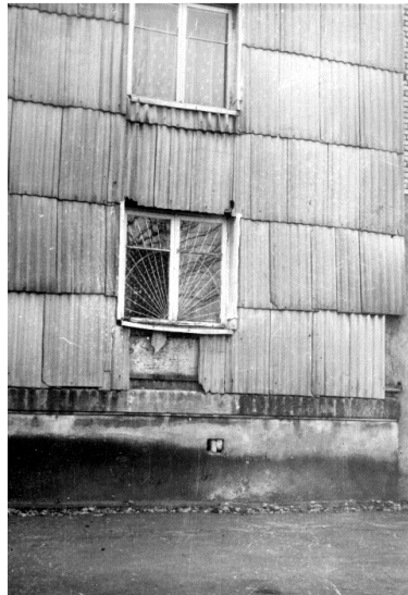
ნახ. 11. ირიბი წვიმებისაგან კედლის დაცვა ასბოცემენტის ეკრანებით.
